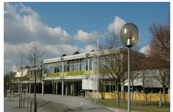
Schulgebäude im Gewerblichen Bildungszentrum Bruchsal
