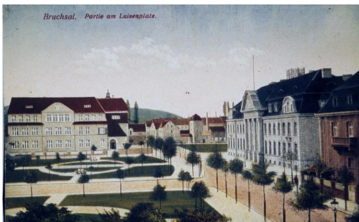
Das 1912 errichtete Schulgebäude am Luisenplatz (links)
